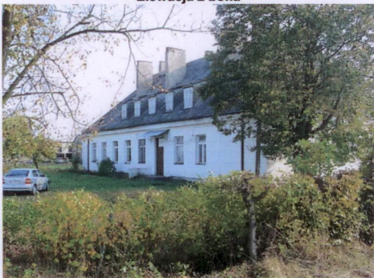
Elewacja od podwórza
