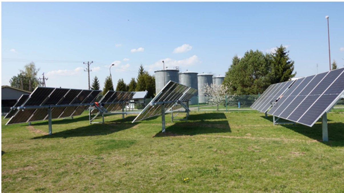
Ryc. 6 Przykład zastosowania jednoosiowych trackerów fotowoltaicznych.
