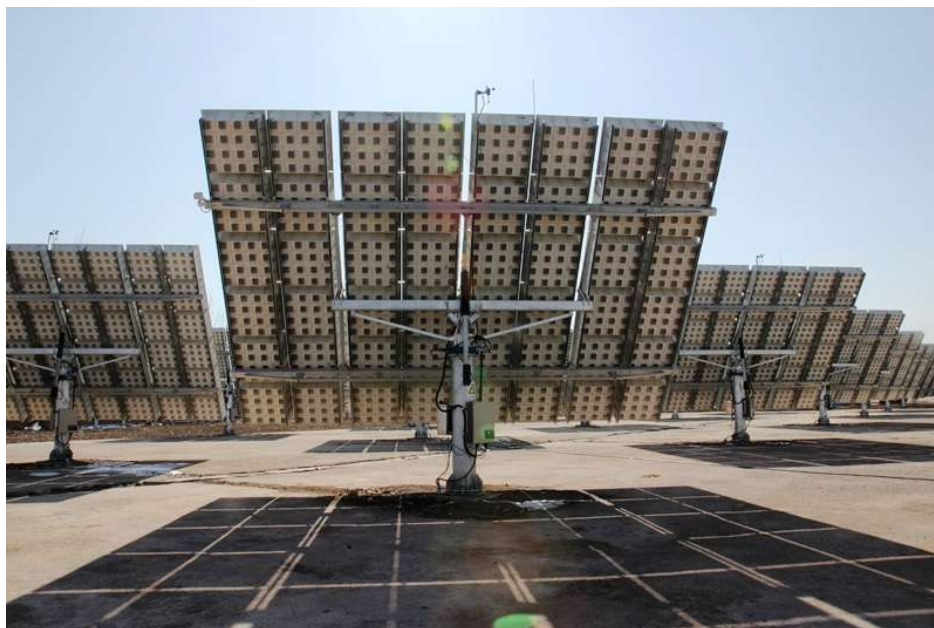
Ryc. 20 Przykładowe moduły z systemem trakcyjnym typu „dual axis”.
