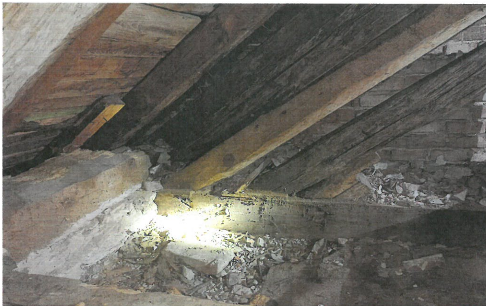
Fot. 6 Połączenie elementów konstrukcyjnych (belki stropowe, krokwie, murlaty). Widoczne zniszczenia wywołane ingerencją owadów (spuszczel pospolity i kołatek domowy) oraz przesuszenia, pęknięcia i odkształcenia. W wielu miejscach ubytki w budulcu.
