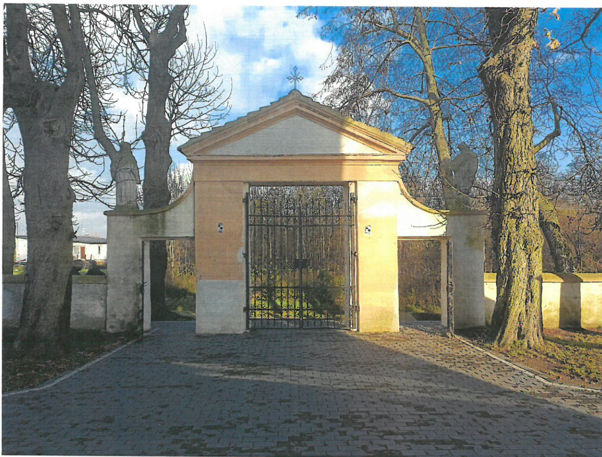
Fot. 37 Główne wejście na teren placu kościelnego. W dolnych partiach widoczne wykwity glonów wynikające z ciągłego zawilgocenia materiału.
