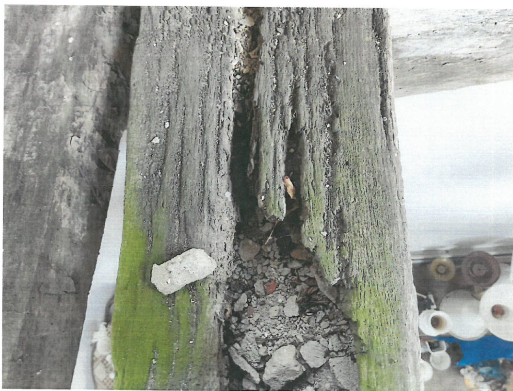
Fot.32 Belki rozporowe puste w środku, nalot wykwitów w postaci glonów
