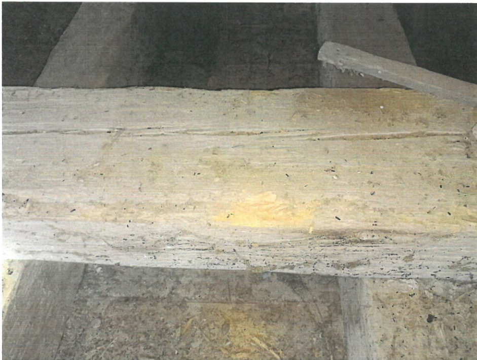
Fot. 4 Belka podwalinowa. Widoczne zniszczenia wywołane ingerencją owadów (spuszczel pospolity i kołatek domowy) oraz przesuszenia, pęknięcia i odkształcenia. W wielu miejscach ubytki w budulcu.
