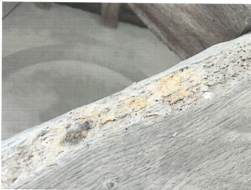
Fot. 34 Drewno porażone żerowaniem kołatka domowego.
