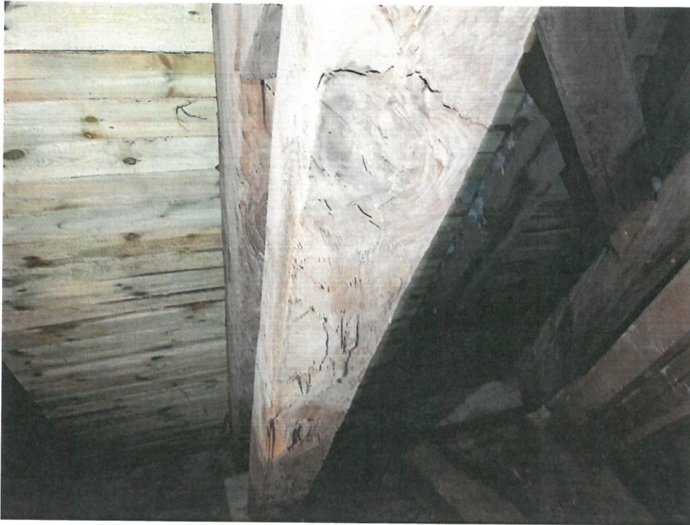
Fot. 12 Na całej długości i szerokości zastrzału widoczne ślady korytarzy żerowania owadów-spuszczel pospolity
