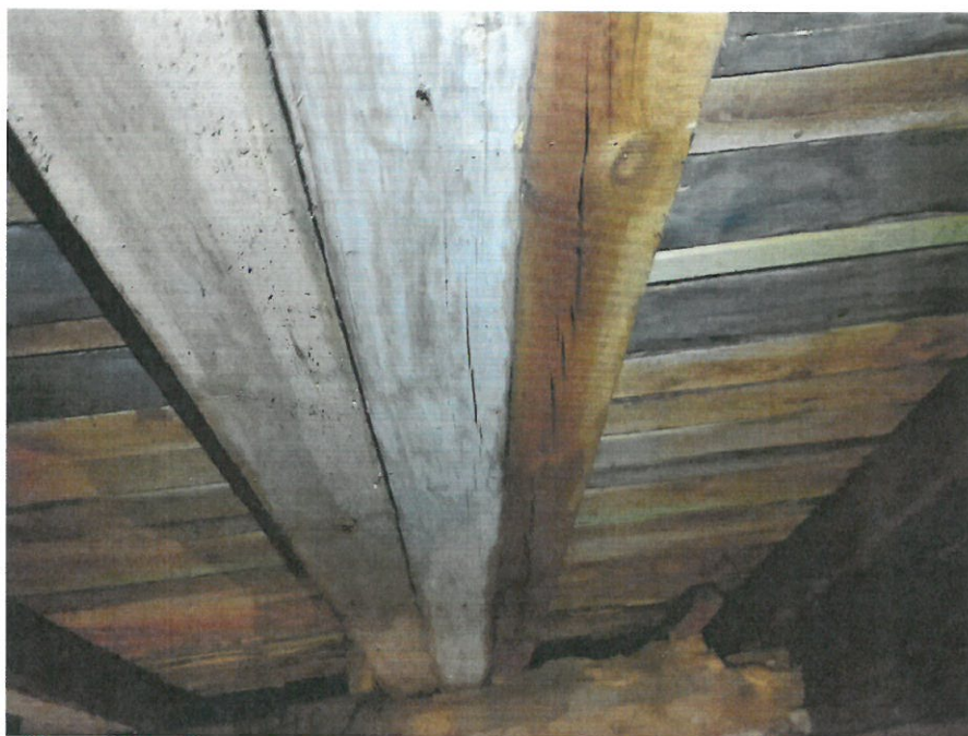
Fot. 16 Wzmocnienie zdegradowanej krokwi.
