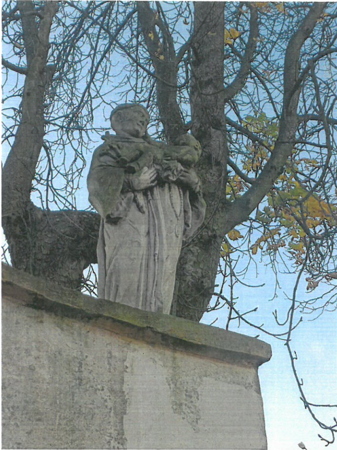
Fot. 41 Wykwity , odspojony tynk, ubytki w detalu figury świętego.
