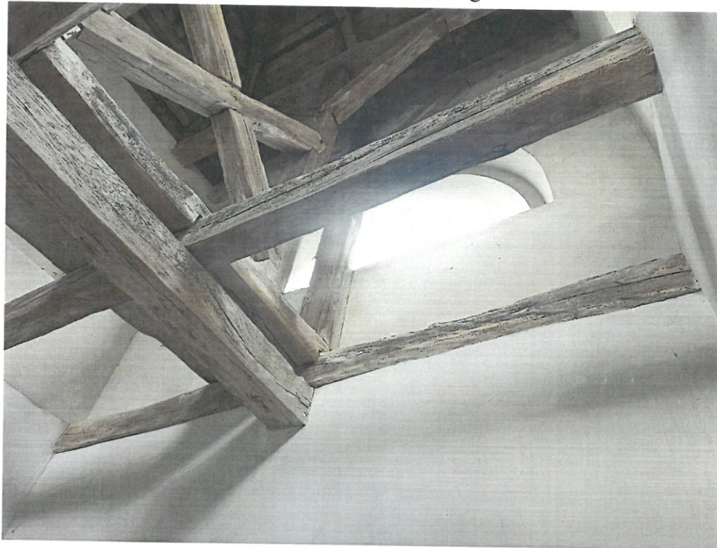
Fot. 29 Belki oparte na bocznych ścianach całkowicie zniszczone, przesuszone, porażone żerującymi owadami.
