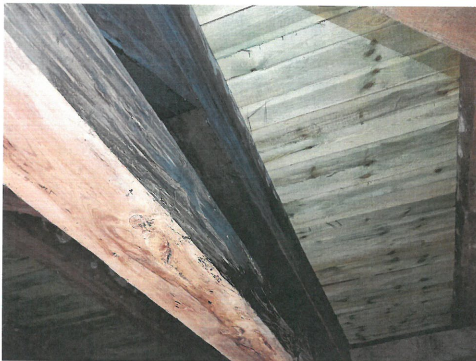
Fot. 10 Wszystkie elementy konstrukcyjne wykonane z drewna struganego (różnice w przekroju)
