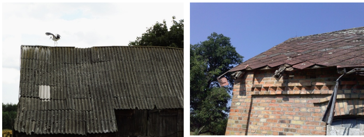
Rys. 1. Wyroby azbestowo – cementowe: po lewej płyty faliste, po prawej płyty płaskie, typ „Karo”. (źródło: materiały własne)
